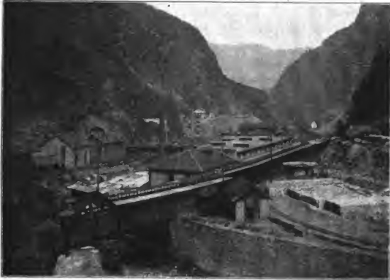
Fig. 9. Installationsplatz für die Tunnelarbeiten in Iselle.
